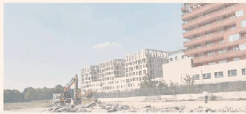
Porta Vittoria. Il complesso a Milano. In primo piano il cantiere per i lavori relativi al parco che Prelios ha appena avviato
